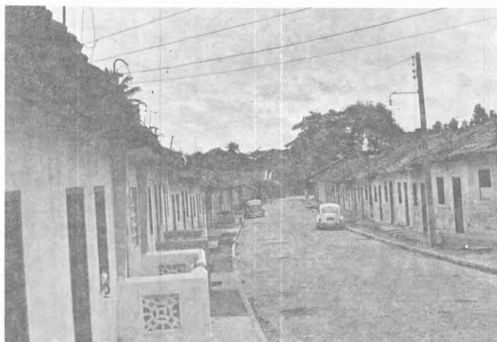
Rua da vila operária no "bairro do Nobre", nas proximidades da Fábrica Arthur. As varandas e basculantes são meios pelos quais alguns moradores de casas próprias distinguem suas casas da uniformidade dos arruados da vila operária.
