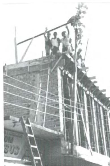
Equipe na construção da nova sede do CSBJ.
